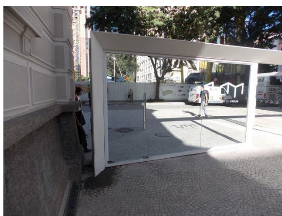
Depois da instalação
