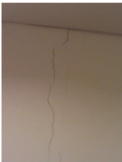
Fotos – rachadura na parede da rampa de saída do Pavilhão de Exposições e na divisória entre loja e café
