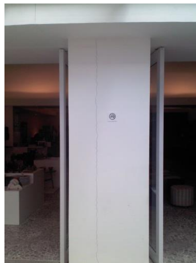
Fotos – rachadura na parede da rampa de saída do Pavilhão de Exposições e na divisória entre loja e café
